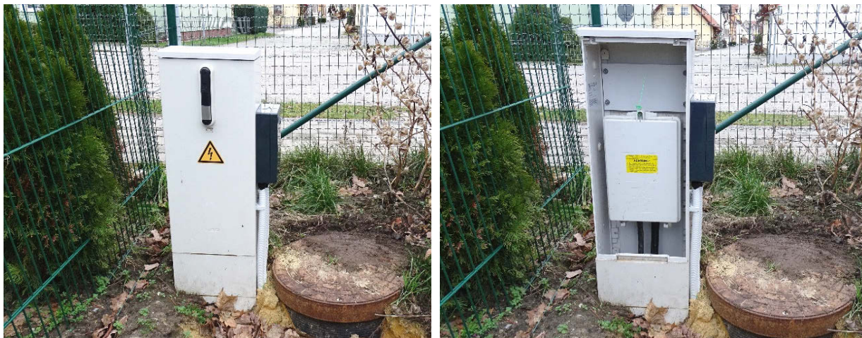
Abbildung 8 + 9: Hausanschlussssäule (verschlossen/geöffnet) im Versorgungsgebiet der VBH
