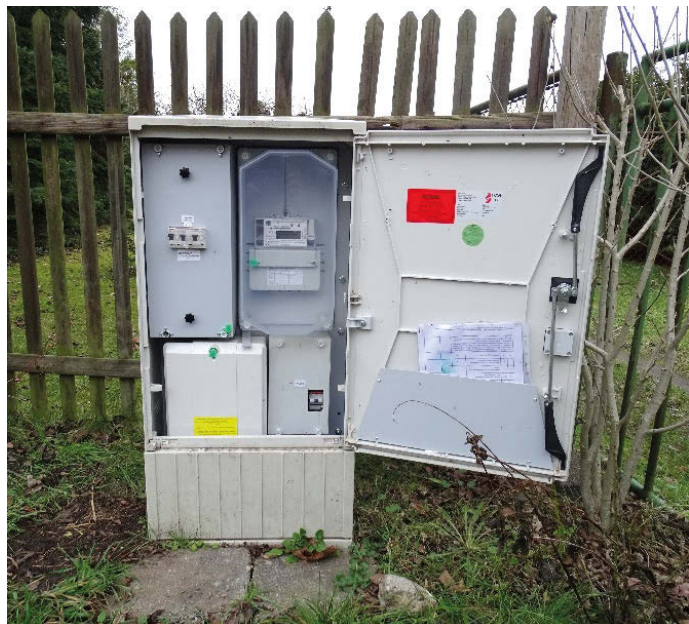
Abbildung 10 + 11: Zähleranschlussssäule (verschlossen/geöffnet) im Versorgungsgebiet der VBH
