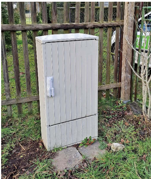
Abbildung 10 + 11: Zähleranschlussssäule (verschlossen/geöffnet) im Versorgungsgebiet der VBH
