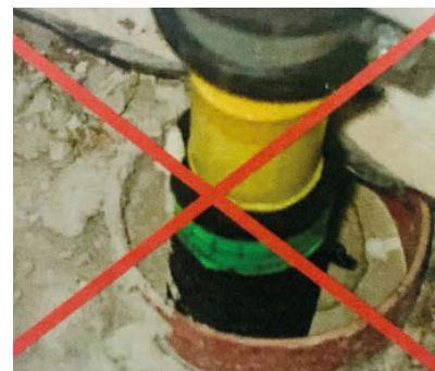
Abbildung 3: KG-Rohr in Betonverguss (Quelle: Emscher Lippe Energie GmbH)
