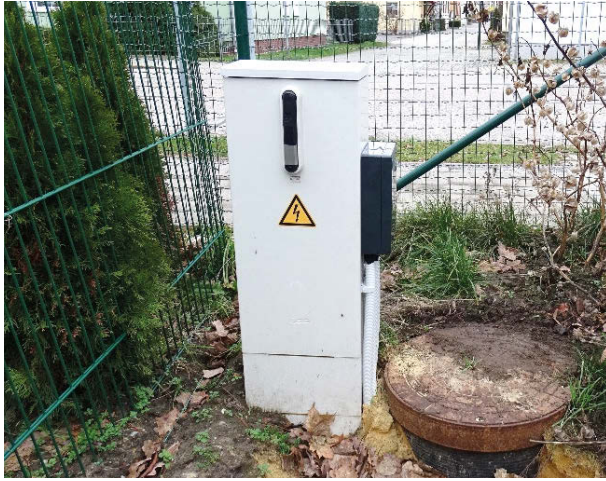
Abbildung 8 + 9: Hausanschlusssäule (verschlossen/geöffnet) im Versorgungsgebiet der VBH
