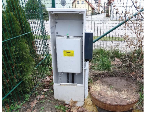
Abbildung 8 + 9: Hausanschlusssäule (verschlossen/geöffnet) im Versorgungsgebiet der VBH
