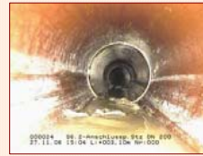
Innenansicht Schmutzwasserkanal
